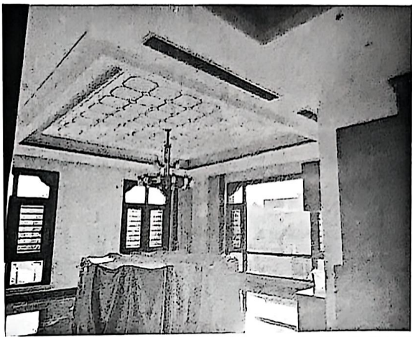
照片18: 室内现状
