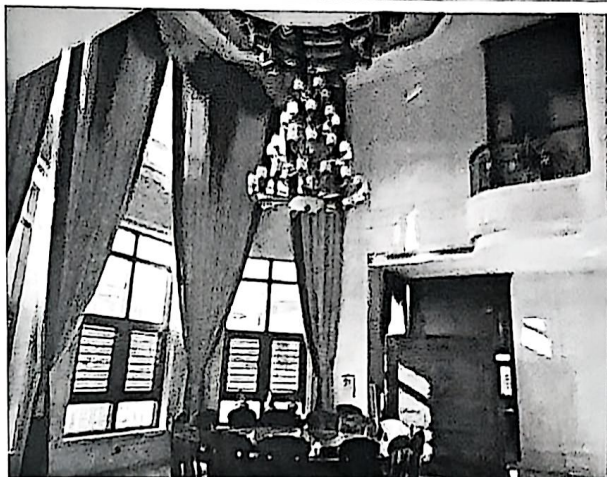
照片 2: 室内现状
