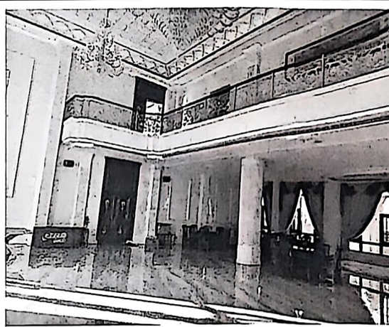
照片 14: 室内现状
