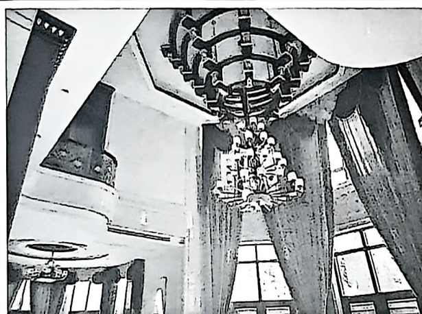
照片 3: 室内现状
